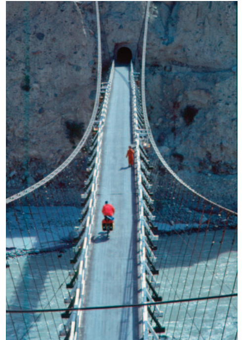
Via een hangbrug over de Hunza verlaten we Gilgit.
